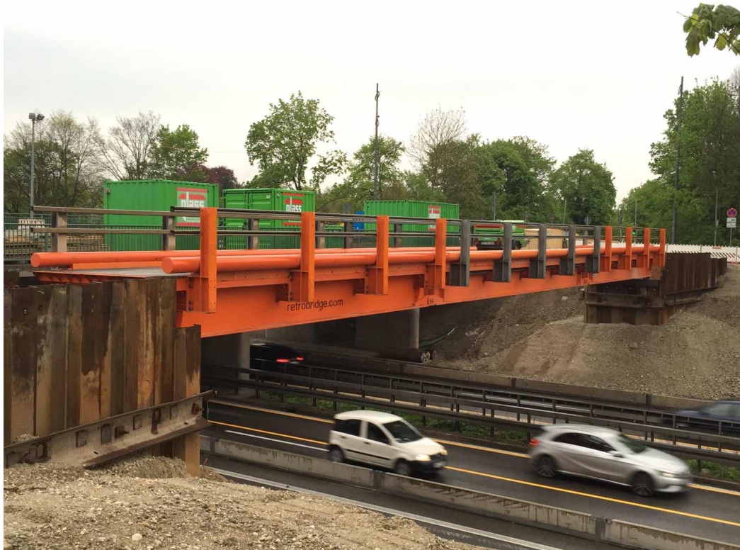
Brücke über der BAB A9 in München im Verlauf der Domagkstraße
