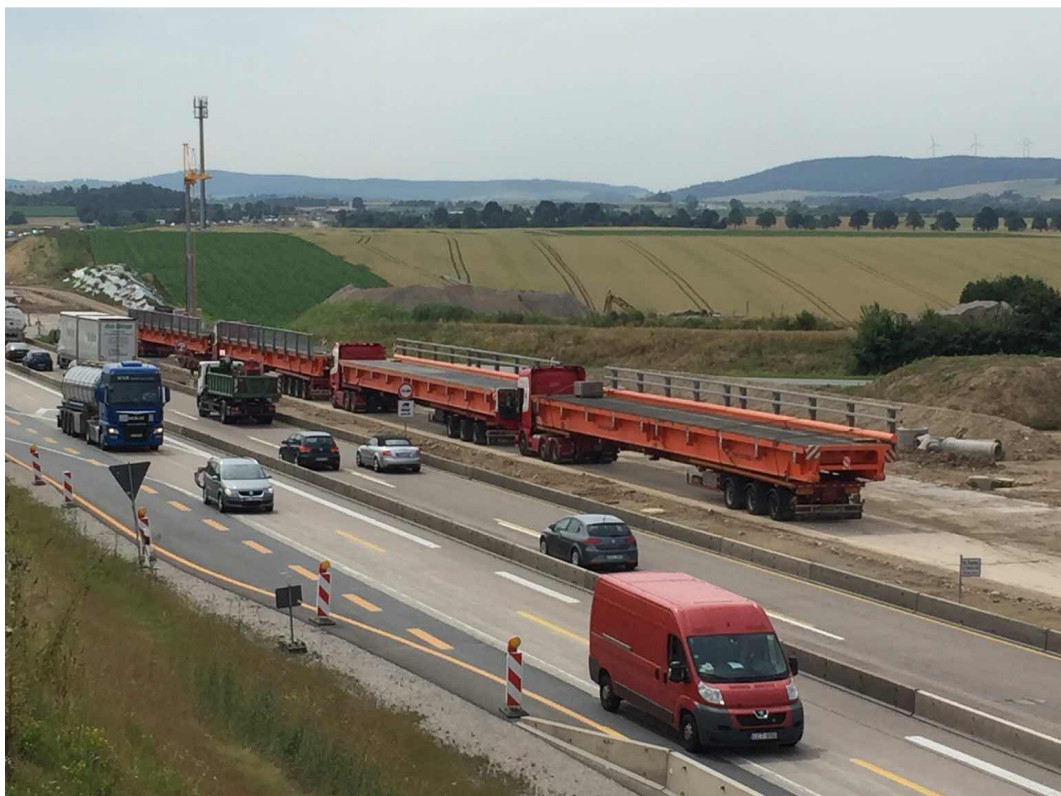
Brückenelemente auf Schwertransportern (Länge je 27,36 m)
