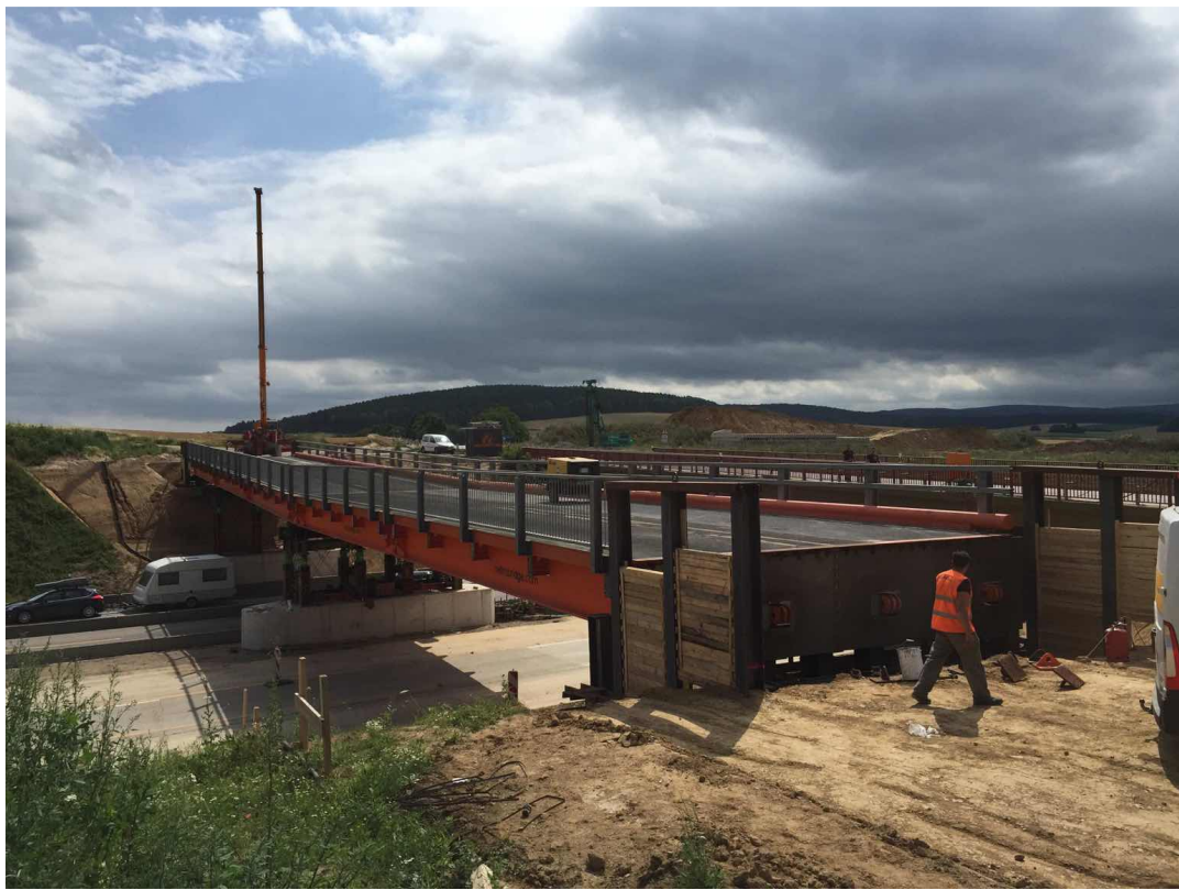
Fertiggestellte Behelfsbrücke im 3-Feldsystem – Gesamtlänge 68,58 m
