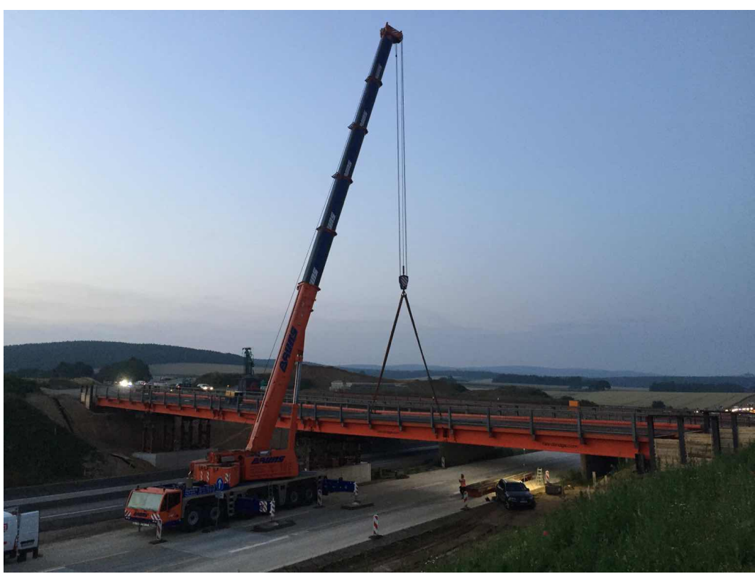
Fertiggestellte Behelfsbrücke im 3-Feldsystem – Gesamtlänge 68,58 m
